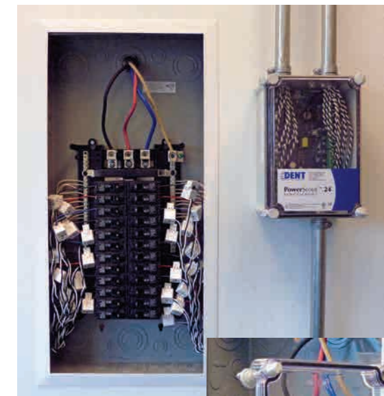
왼쪽: PowerScout 24은 단상 또는 3상 부하의 어떠한 조합에서도 24개까지의 CT를 사용 가능. 한 대의 미터로 건물에 있는 여러 대의 크고 작은 부하들을 모니터링하기 위해 DENT의 RoCoil 또는 Split core 조합으로도 매칭이 가능.
